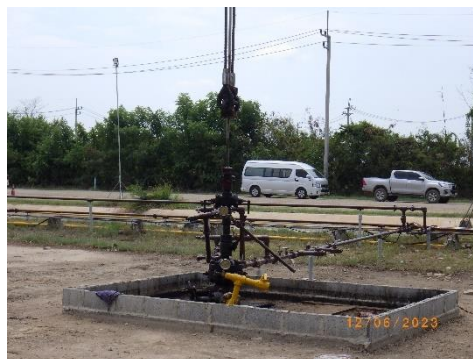
รูปที่ 2-11 คันคอนกรีตล้อมรอบหัวหลุมผลิต
