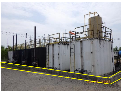
รูปที่ 2-10 ถังเก็บน้ำมันดิบและน้ำจากกระบวนการผลิตจัดวางบนพื้นคอนกรีตพร้อมคันคอนกรีตล้อมรอบ
