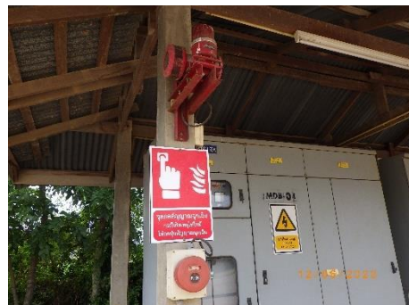
อุปกรณ์ส่งสัญญาณเตือนเหตุเพลิงไหม้
